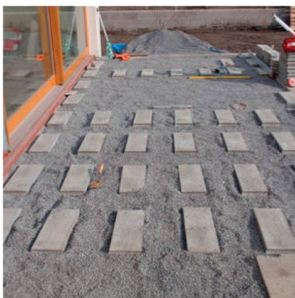
zhuťněné štěrkopískové lože s betonovými podpěrami
